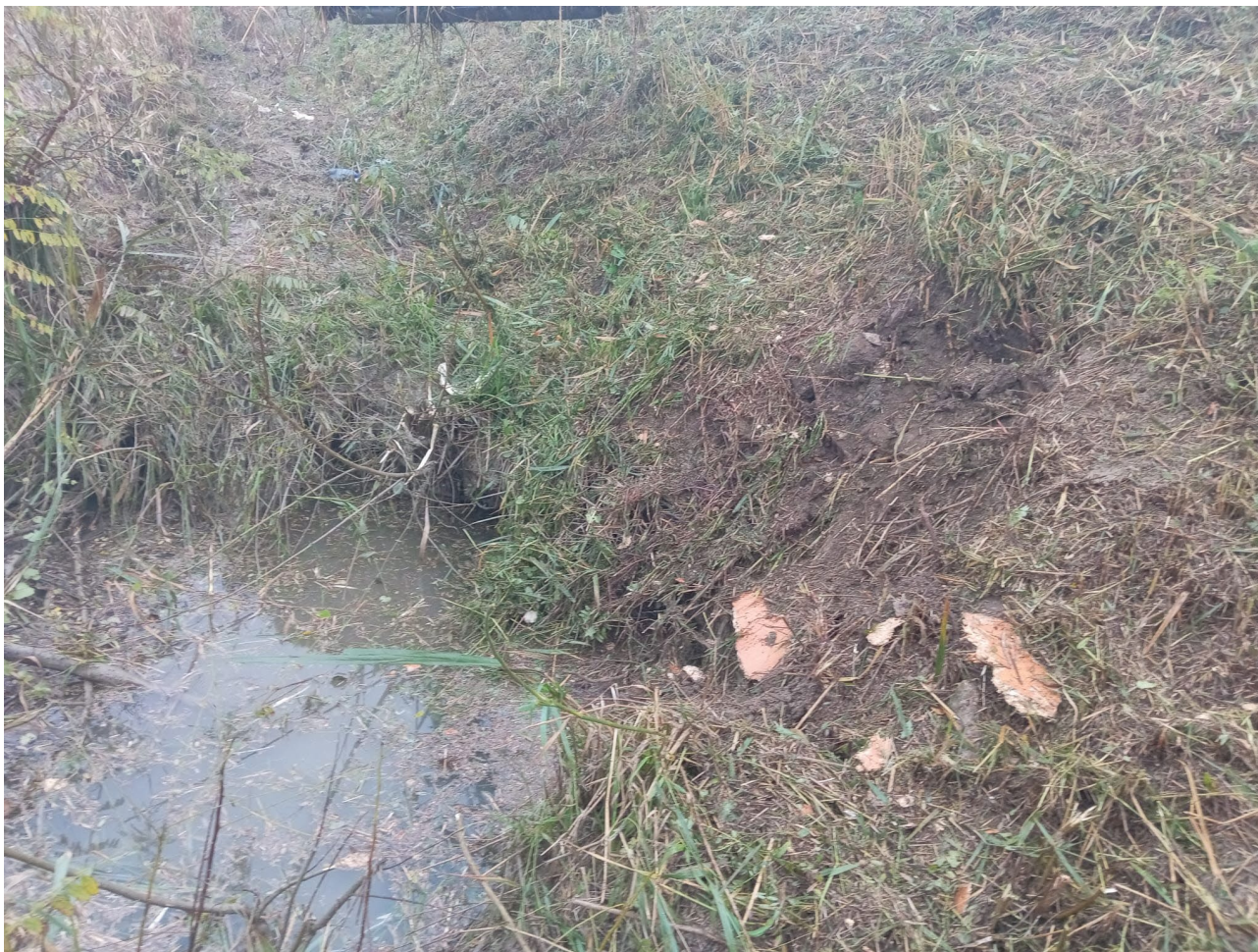
Foto n. 2 - Un particolare dell'erosione del piede della scarpata a fiume (frollo)
